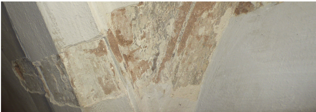
sonda 4: nejstarší omítková vrstva s profilací je patrně až klasicistní
