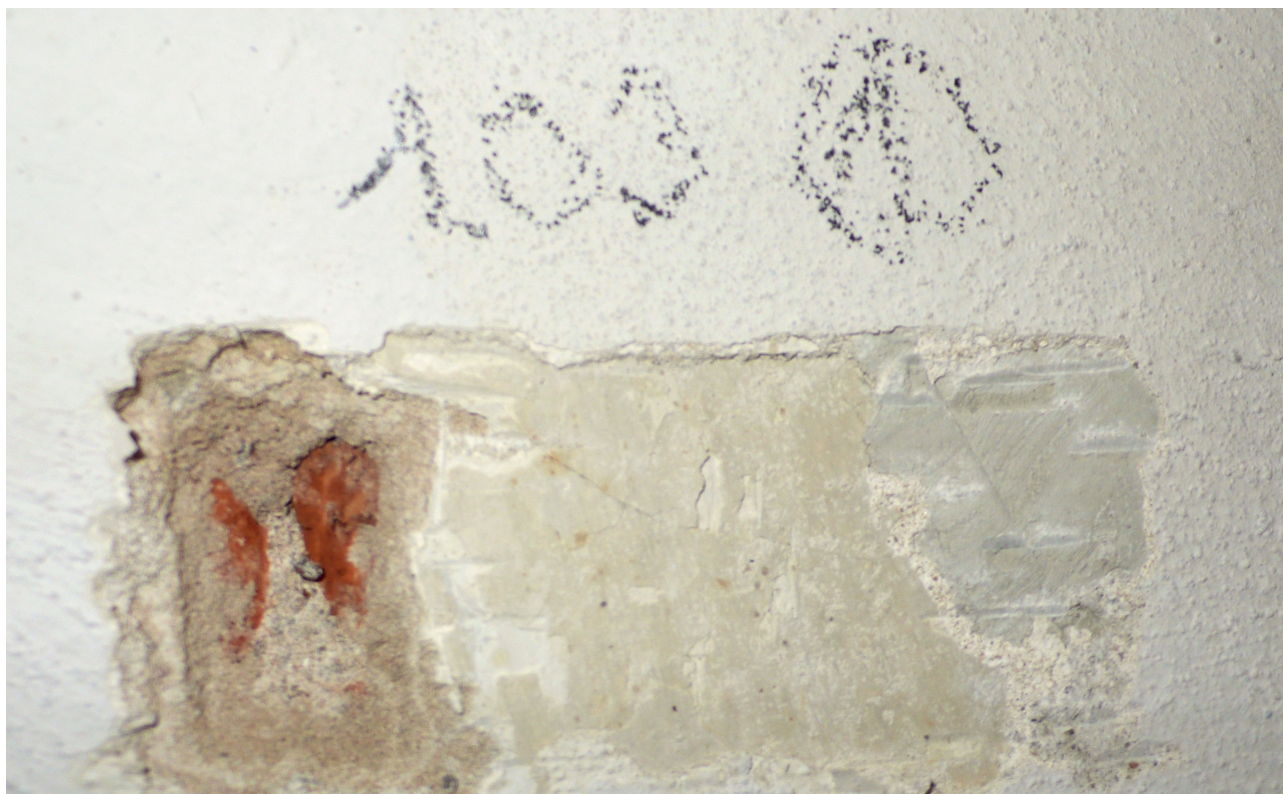
sonda 1: nejstarší omítková vrstva s bílými vápennými nátěry
