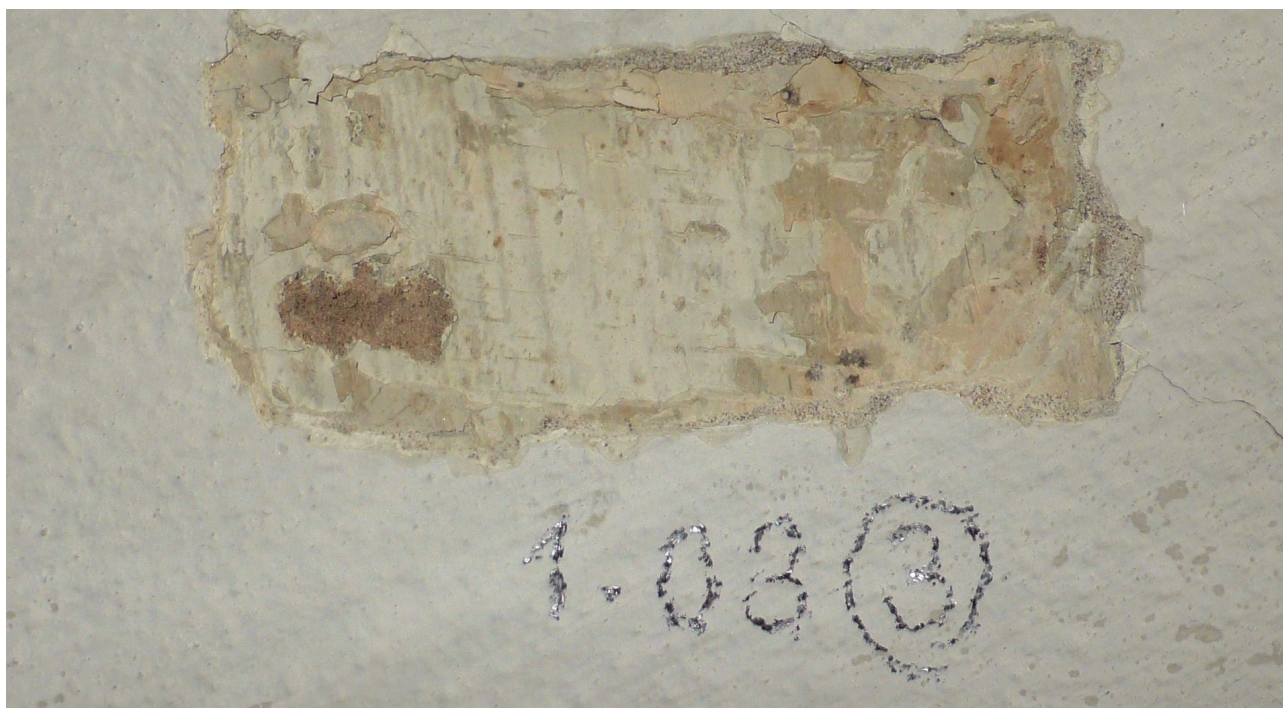
sonda 3: nejstarší omítková vrstva s bílými vápennými nátěry
