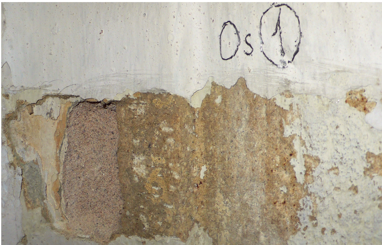
sonda 1: na kameni vrstva s okrovým vápenným nátěrem
