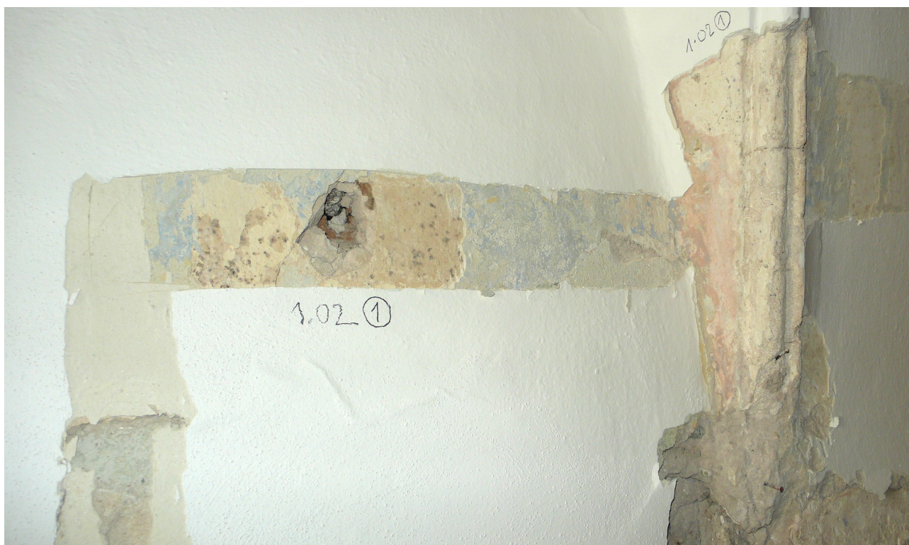
sonda 1: původní světlý krémový nátěr na původním profilu omítek a mladší barevné úpravy
