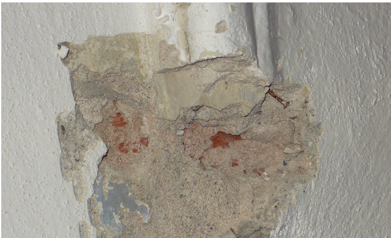
profil hřebínku (žebra) je nově vytažen ve štukce a originální omítky na mnoha místech chybí
