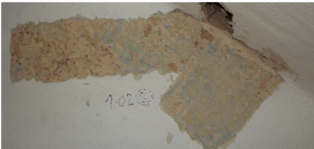
sonda 3: zbytky barevných úprav na původní omítce s režným (krémovým) vápenným nátěrem
