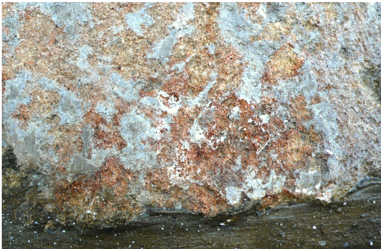
kamenný sloup ve východním pilíři arkády loubí: zbytky šedých vápenných nátěrů, pod nimi červený odstín
