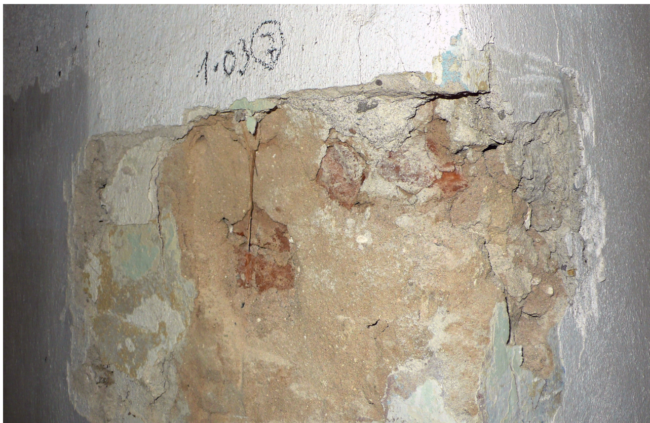
sonda 7: nejstarší omítkové vrstvy
