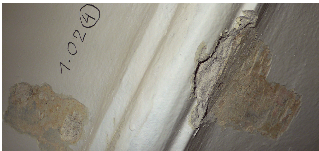
sonda 4: profil hřebínku (žebra) je nově vytažen ve štku a originální omítky mnohde chybí
